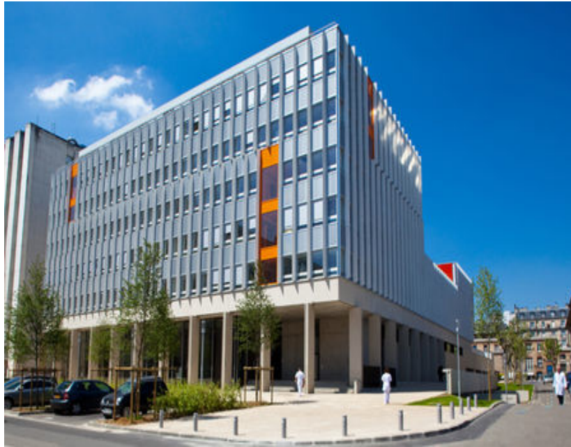
Bâtiment Jean Dausset
